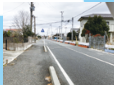
分断された道路。左は避難解除地域、右は避難指示地域
